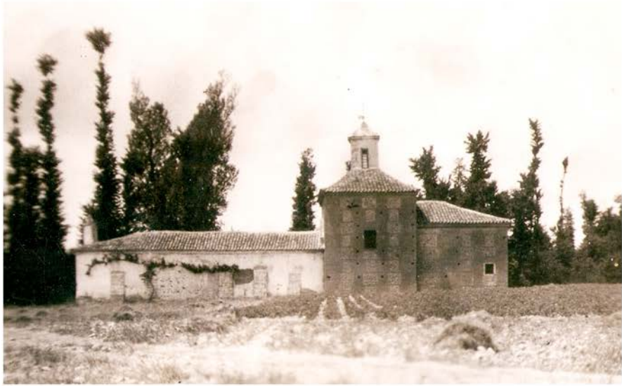
Ermita de la Virgen de la Granja, antes de expirar el siglo XIX. La nave bien puede ser de fines del siglo XIV o principios del XV. La capilla mayor y la sacristía-camarín fueron edificadas entre 1696 y 1701. Un patronato velaba por el mantenimiento del culto y su hacienda. (Gentileza de Gregorio Santiago Redondo).
